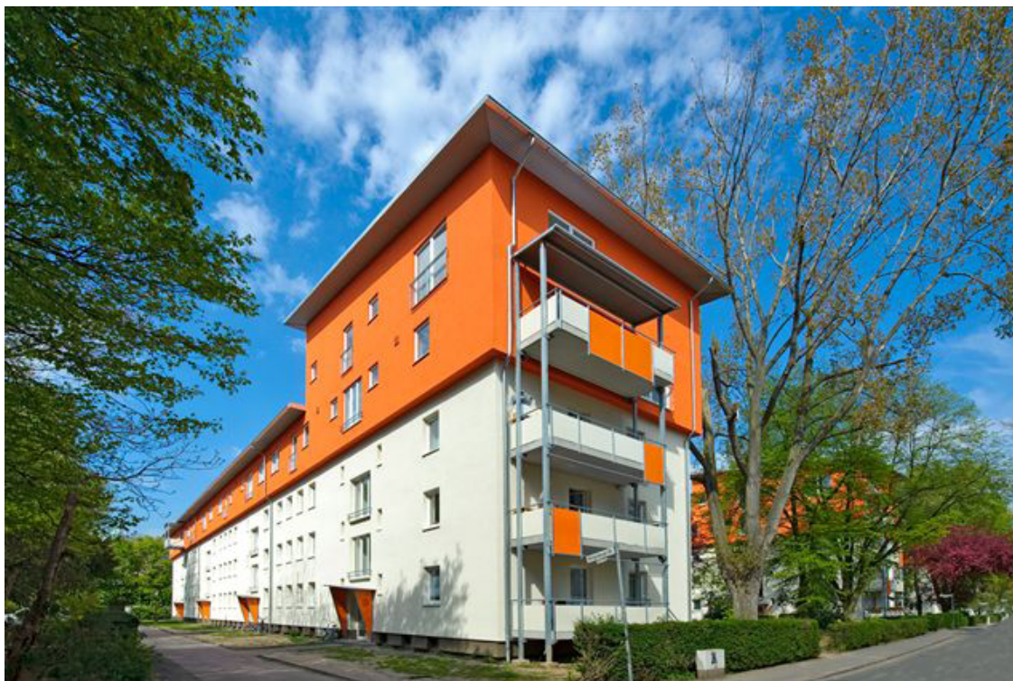
Beispiel einer gelungenen Dachaufstockung derLEG-NRW in Köln. Foto LEG-NRW
