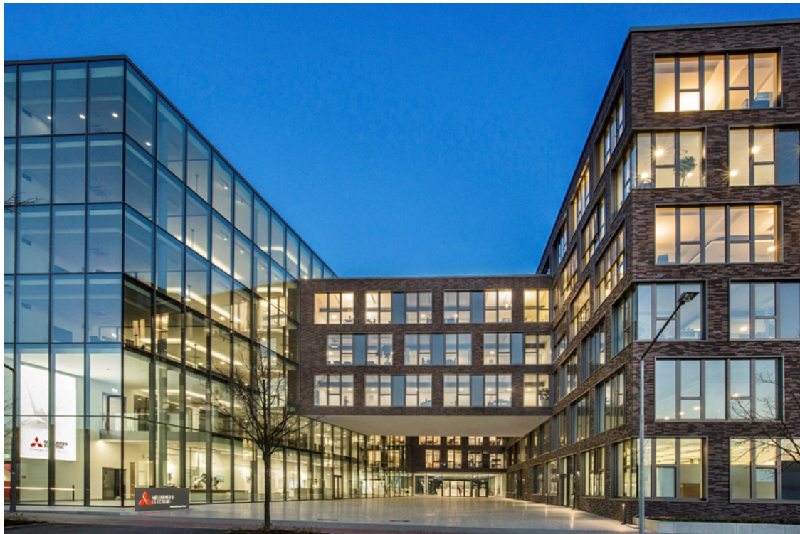
Deutschland-Zentrale von Mitsubishi Electric in Ratingen. Die eingesetzte Technologien decken gesamten Wärme- und Kältebedarf des Gebäudes ab. Foto: Mitsubishi Electric
