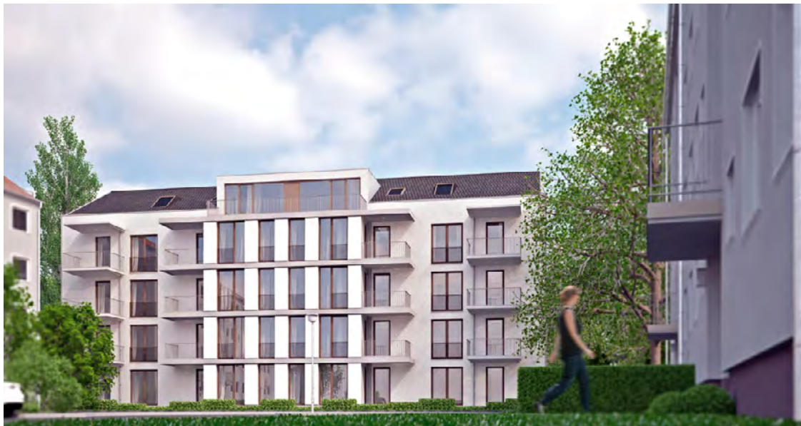
Südansicht des Passivhauses im Bremer Stadtteil Findorff. Foto: GEWOBA
