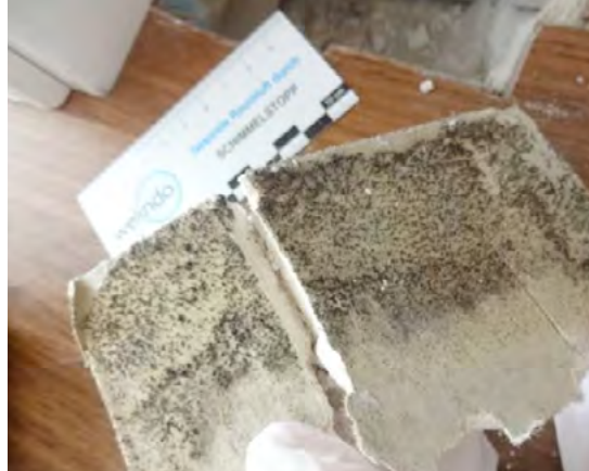
Braun-graue bis schwarz-graue Verfärbungen an Wandoberflächen sind auf Schimmelschäden zurückführbar
