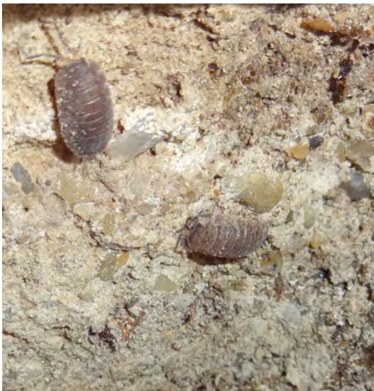
Kellerasseln in der Fußbodenkonstruktion eines Bades
