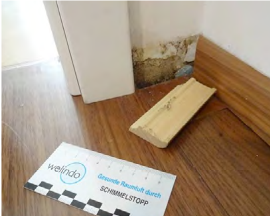
Braun-graue bis schwarz-graue Verfärbungen an Wandoberflächen sind auf Schimmelschäden zurückführbar
