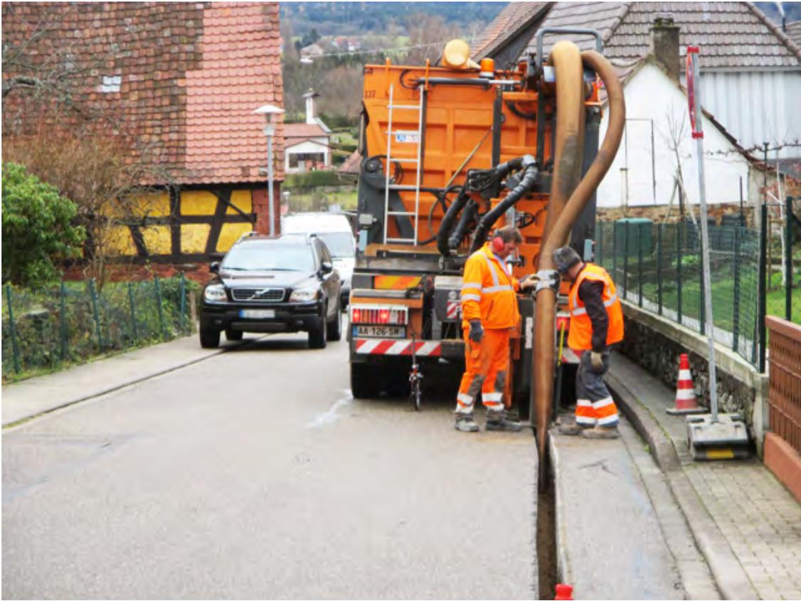
Durch das direkte Absaugen des Aushubs bleibt die Straße sauber und der Graben bietet einen festen Stand, so dass die Rohre sofort verlegt werden können.
