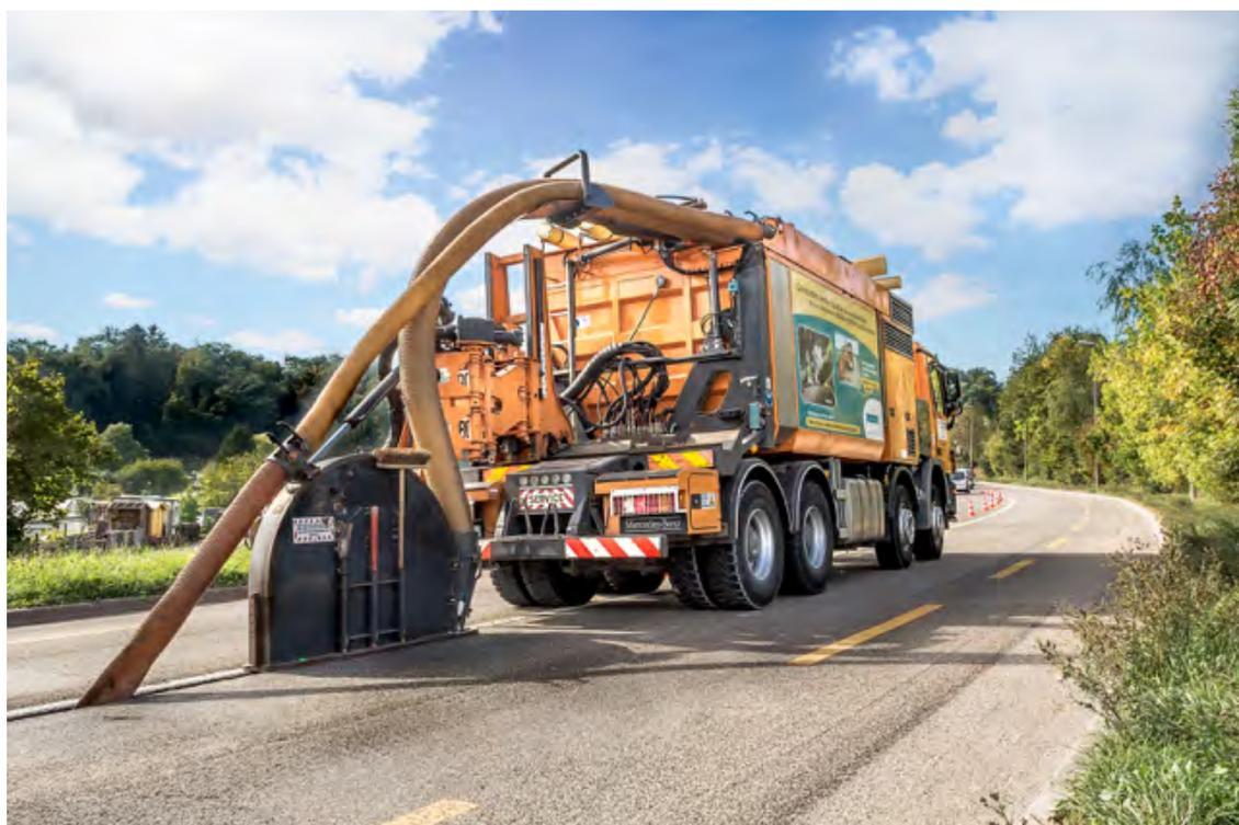
Die Cleanfast-Fräse fräst durch die Asphaltsschicht einen schmalen Kanal tief in den Boden. Alle Fotos: Leonhard Weiss
