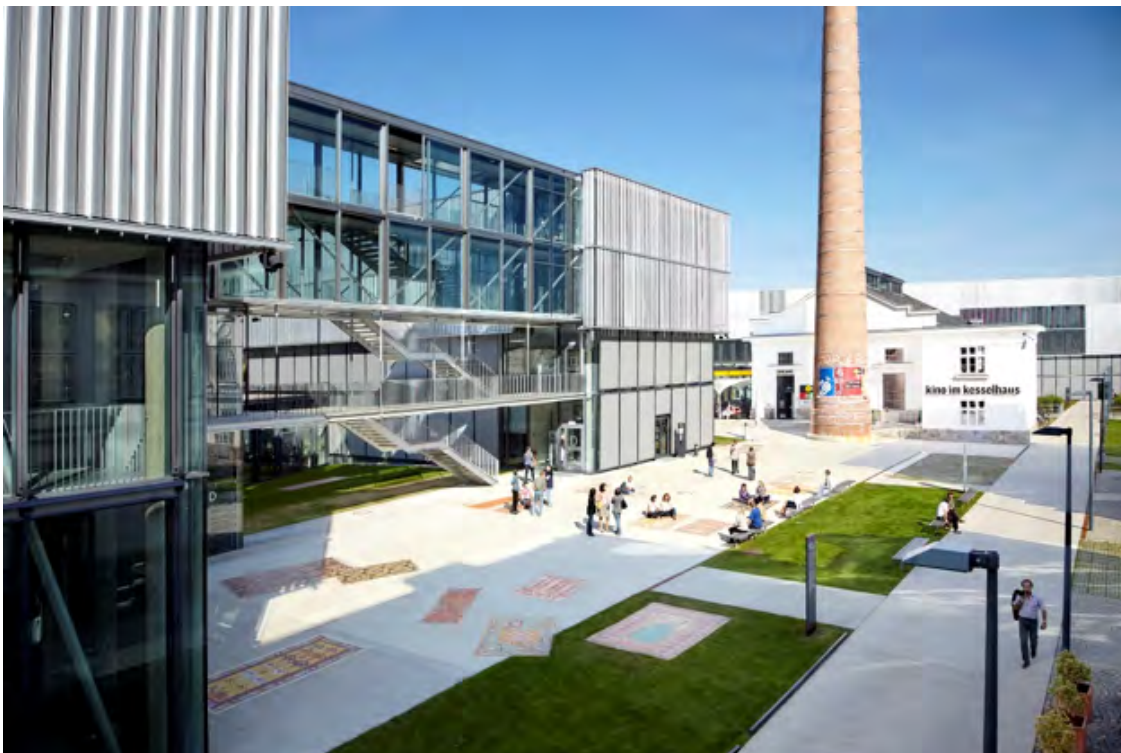
Forum Campus Krems mit Neubau der Donau-Universität Krems und Kino im Kesselhaus im Hintergrund; Foto Suzy Stöckl
