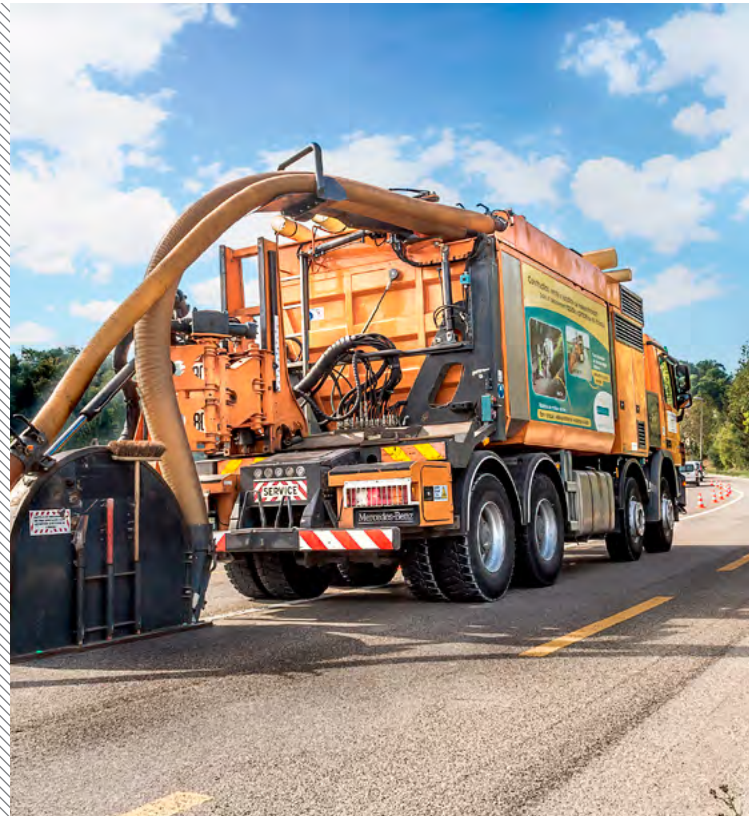
Glasfaserverlegung kostengünstig; Foto Leonhard Weiss
