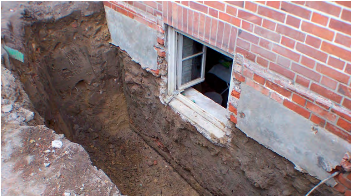
Vor der Sanierung steht die Beratung. Foto: VPB
