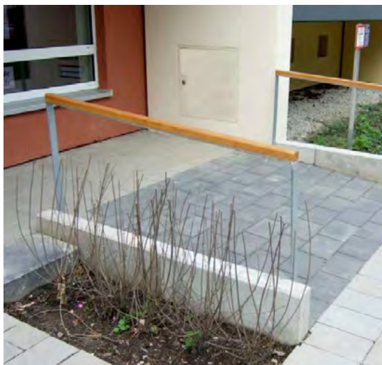
Barrierearmer Zugang ins Wohnhaus.
