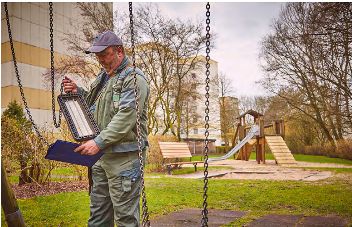
Halten die Kettenglieder noch, oder sind sie schon zu weit durchgescheuert? Foto: Kasper Fuglsang
