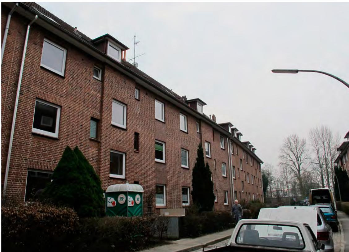
Echtes Vorzeigeprojekt: Mit Kraft-Wärme-Kopplung und dezentraler Trinkwassererwärmung ist das 1930 gebaute Mehrfamilienhaus technisch nun auf dem neuesten Stand. Fotos und Zeichnung: Danfoss
