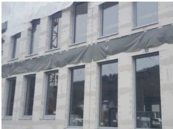
Die vorgefertigte Außenwand. Foto: ELISSA
