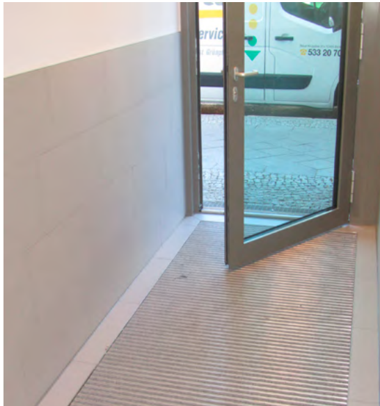
Rutschhemmender Bodenbelag im Eingangsbereich. Foto entnommen aus der Studie „Barrierefreies Wohnen im Kostenvergleich“
