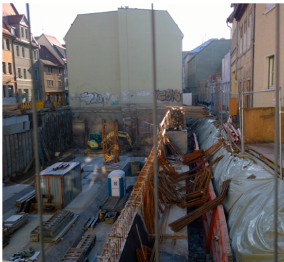
Beim Kellerbau kommt es auf jedes Detail an, deshalb klären Sie vorher genau die einzelnen Schritte. Foto: Gerd Warda
