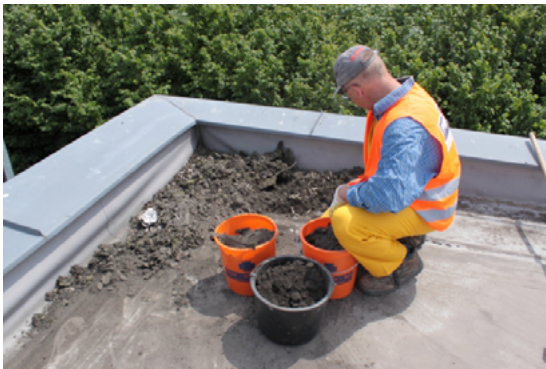
Die vereinbarte Leistung wird durch den Handwerker durchgeführt. Foto: Solutiance
