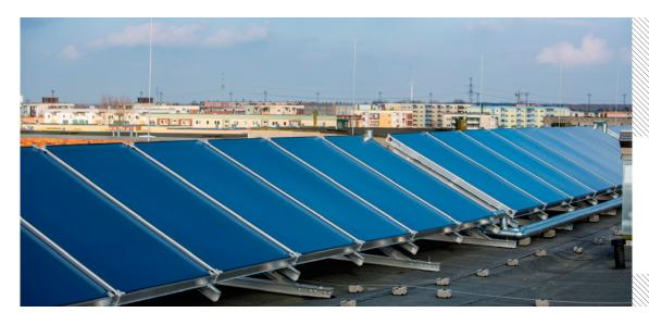
Wärme für die Warmwasseraufbereitung liefern die Solarkollektoren auf den Flachdächern und reduzieren so den Gasverbrauch. Foto: Jens Scholz.
