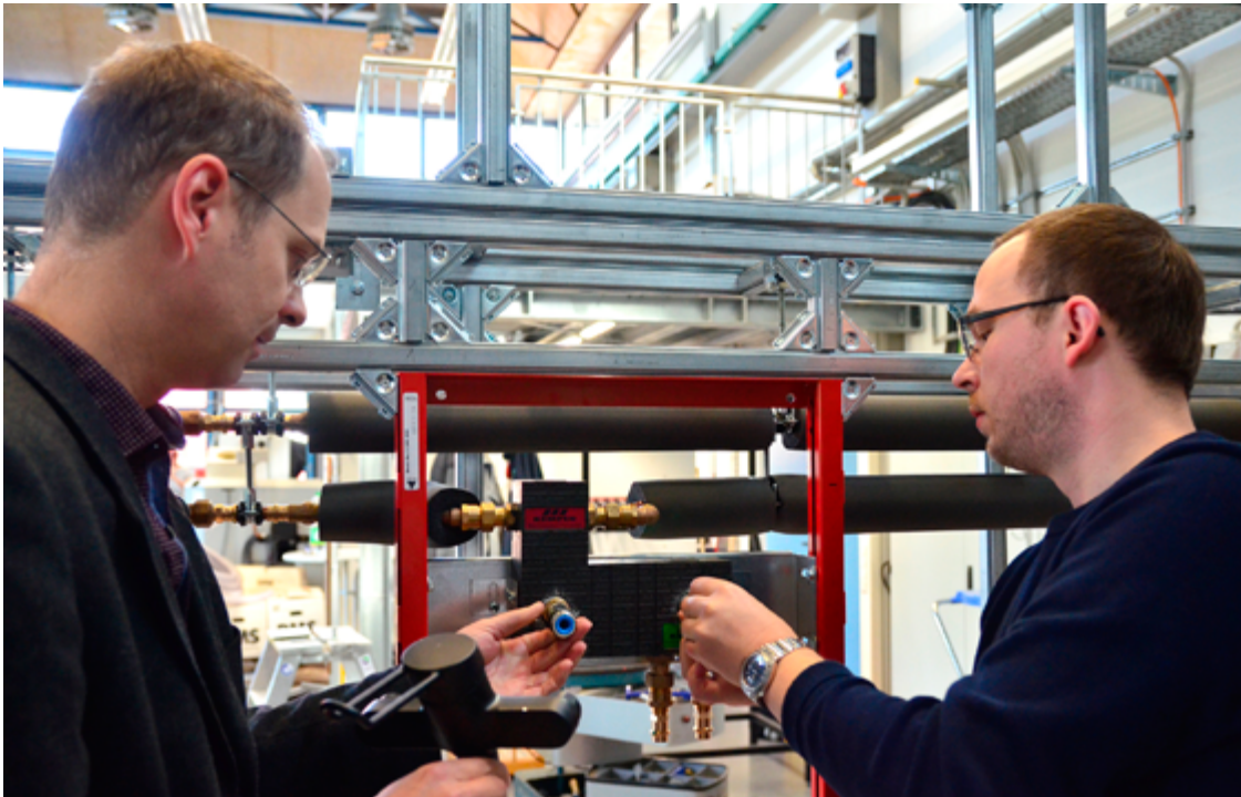
Prof. Dr. Carsten Bäcker (l.) und Stefan Brodale schließen eine Armatur an ihr aufgebauten Trinkwasser-Installationsmodell mit Warm- und Kaltwasserleitung an. (Foto: FH Münster/Pressestelle)
