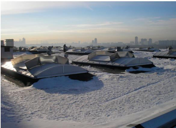
Bei Schnee auf dem Dach eine Gefahrenquelle, deshalb müssen nicht begehbare Dachflächen mit dauerhaften Umwehrungen, Brüstungen oder Unterfangungen ausgestattet sein. Foto: FVLR
