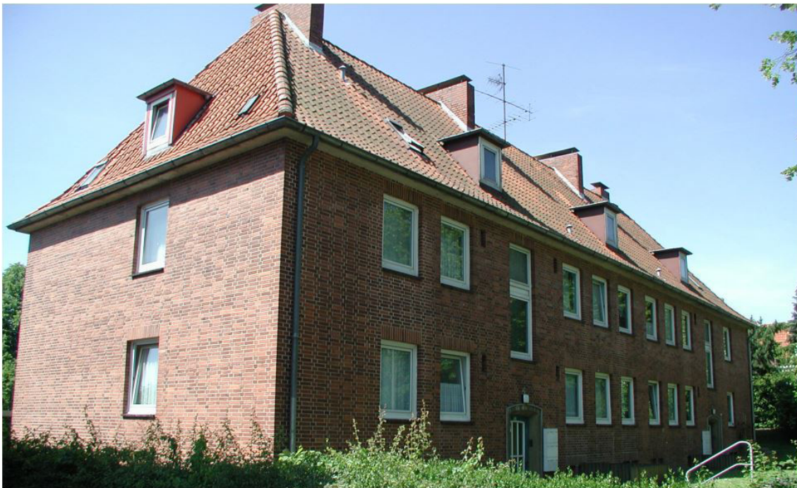
Die NEUE LÜBECKER nahm mit fünf Gebäuden an der Verbandsinitiative „ALFA-NORD“ teil und optimiert somit den Energieverbrauch und die Kosten für ihre Mitglieder sanken bis zu 16 %. Foto: NL
