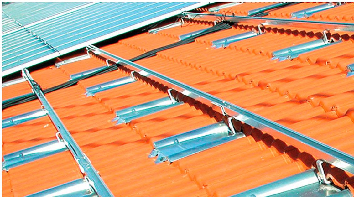
Die innovative Metalldachplatte der Marzari Technik GmbH aus Leutkirch macht Schluss mit kostspieligen Dachschäden durch die unsachgemäße Montage von Solaranlagen. Foto: Marzari Technik GmbH
