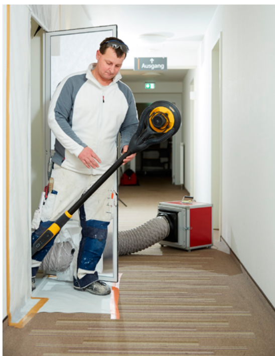
Beschäftigter mit Trockenschleifer für Decken und Wände mit ergonomischer Verlängerung. Im Hintergrund befindet sich ein Luftreiniger. Foto: Dominik Buschardt
