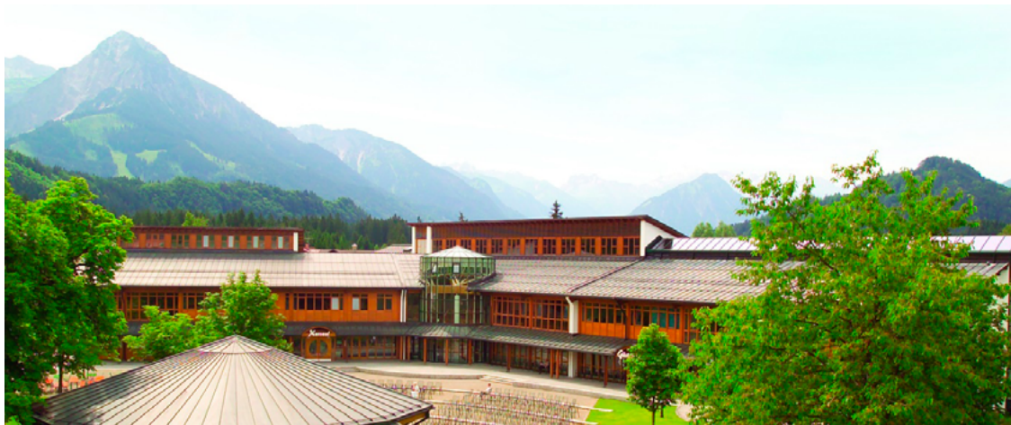
44. Fachgespräch zum WEG - WEG 2020: Baustellen im Wohnungseigentumsrecht - 24.-26. Oktober in Fischen im Allgäu. Foto: eid/Fischen
