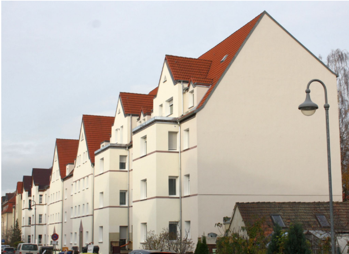
Fassade der UNITAS-Objekte in der Delitzscher Friedrich- Naumann-Straße 21- 27, Quelle: UNITAS
