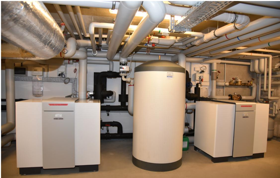
Ein Technikraum des zweiten Bauabschnitts. Diese Wärmepumpen versorgen gleich mehrere Wohneinheiten mit Wärme und sind über das ISG (Internet-Service-Gateway) auch aus der Ferne zu warten; Foto: Stiebel Eltron
