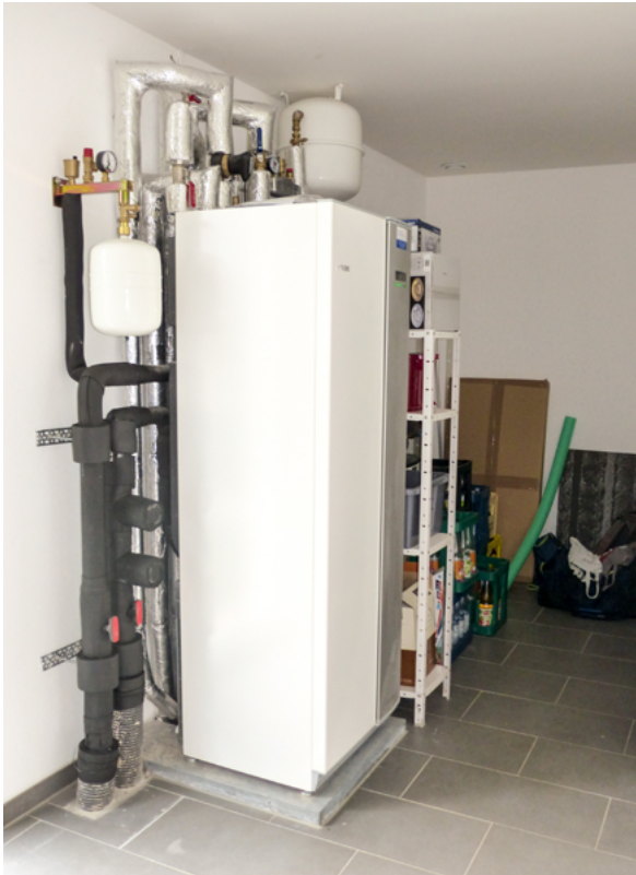
Kompakt, aber wartungsfreundlich, die eingesezte Wärmepumpe im Gebäude. Foto: bwp
