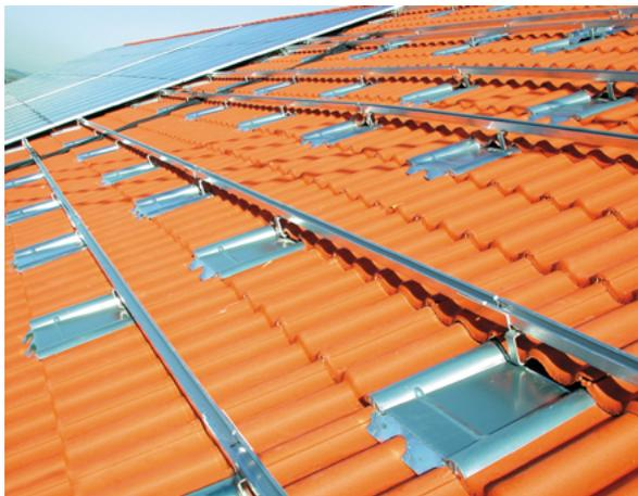
Die innovative Metalldachplatte macht Schluss mit kostspieligen Dachschäden durch die unsachgemäße Montage von Solaranlagen.
