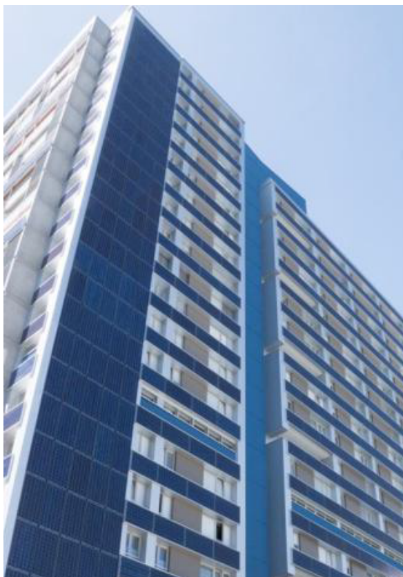
Im Zuge der energetischen Sanierung eines Wohnhochhauses im schweizerischen Bern wurden unter anderem Photovoltaikanlagen an der Außenfassade und auf dem Dach angebracht. Foto: Swissrenova AG
