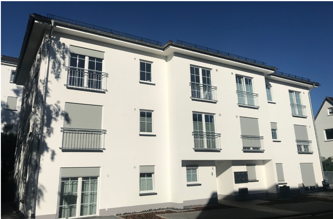
5 Wohneinheiten in Schmallenberg. Heizung und Warmwasser kosten rund 30 Euro im Monat. Foto: alpha innotec
