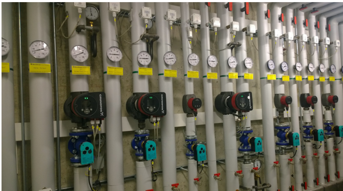
Altbau und Neubau, 1000m 2 mit Erdwärme beheizte Fläche. Ein Blick auf das Verteilsystem. Foto: Gerd Warda
