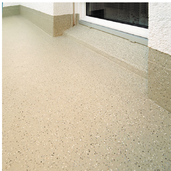
Details wie Anschlüsse an Türen werden mit Flüssigkunststoff homogen in die Abdichtung integriert Foto: Triflex
