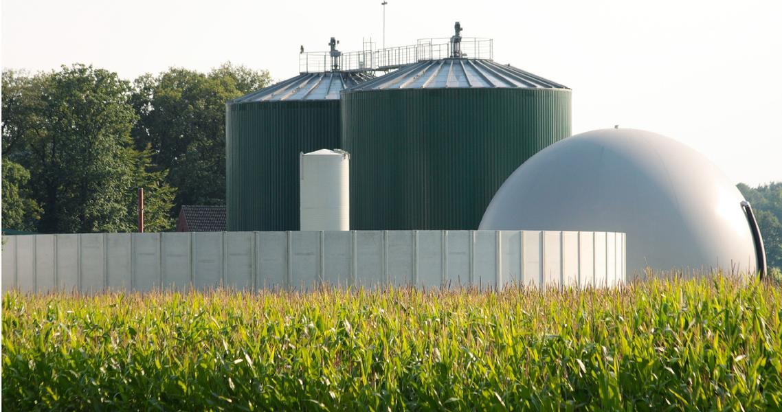
Die Energie für das Nahwärmenetz kommt von einer Biogasanlage wie dieser und soll über einen zentra- len Wärmetauscher mit Wärmespeicher an die einzelnen Neubauten im Gebiet „Dammacker 2“ in Schaff- lund verteilt werden. Foto: © Dirk Grasse/piclease
