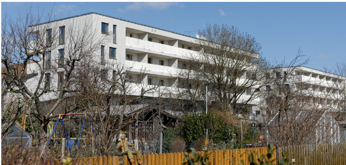
Blick von Südwesten auf die neuen GEWOFAG-Gebäude an der Brantstraße. Foto: Roland Weegen
