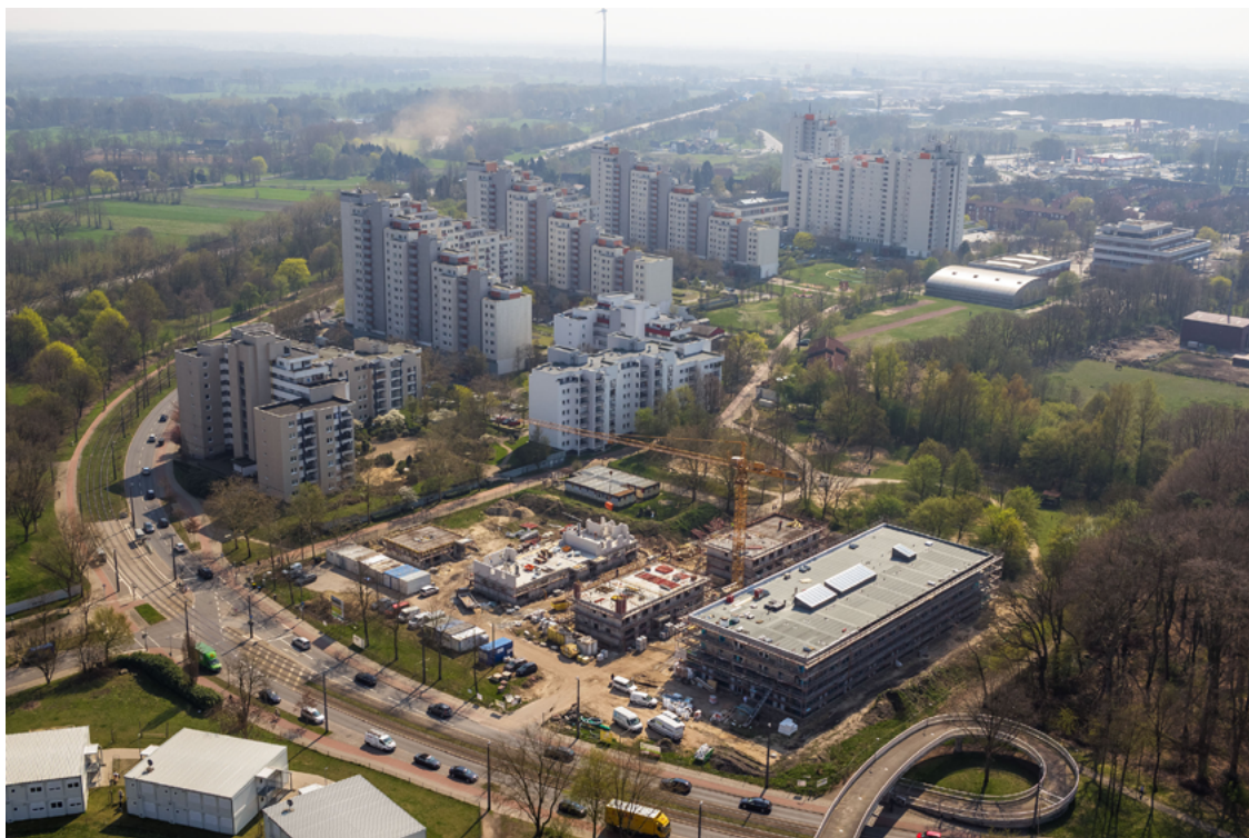
Luftaufnahme Tenover: Vorn sehen Sie den Neubau des Atrium-Hauses. Foto: GEWOBA
