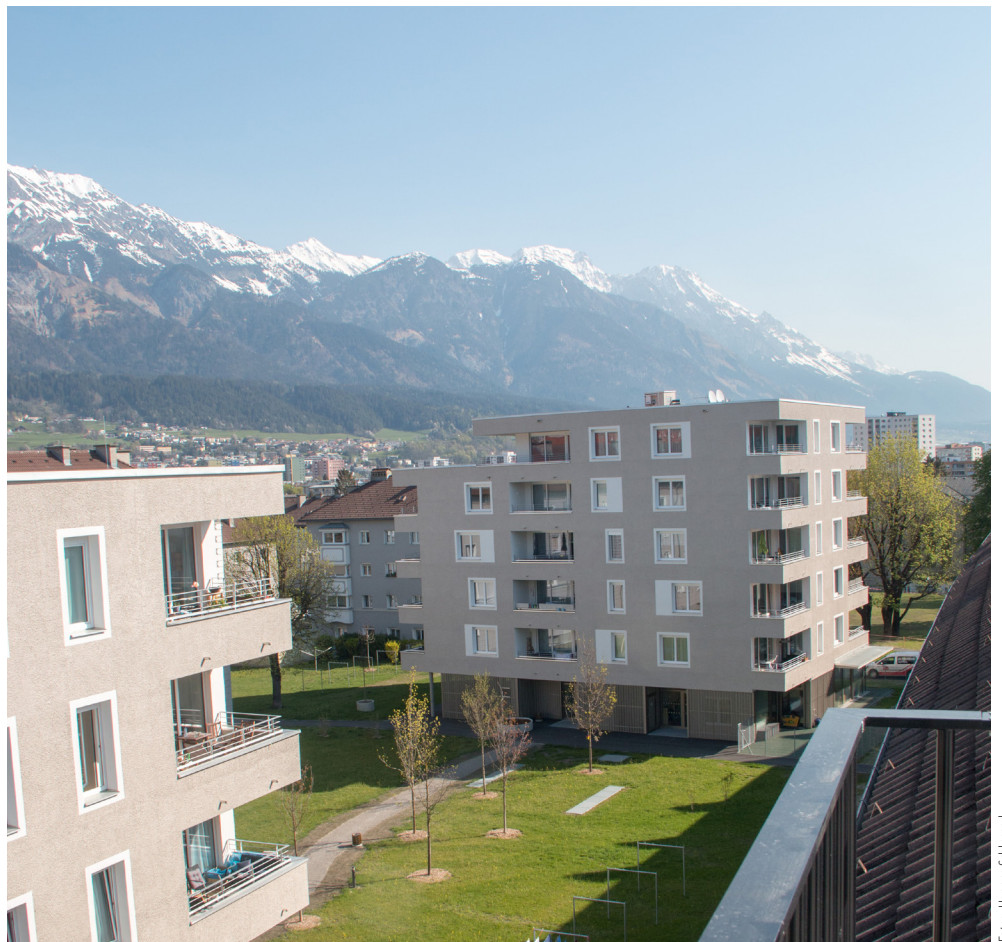
Wohnbau Innsbruck Pradl – Zwei neue Solitärebauten im Innenhof des Altbestandes.
