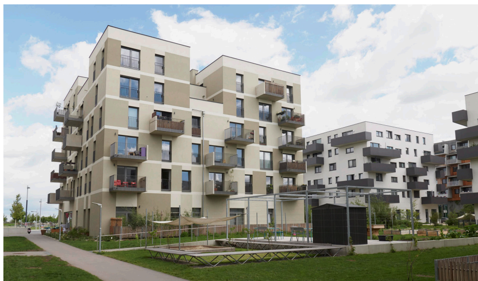
Ziegel-Pionier: Das Baugruppen-Haus der „Drei Schwestern“ in der Seestadt Aspern.
