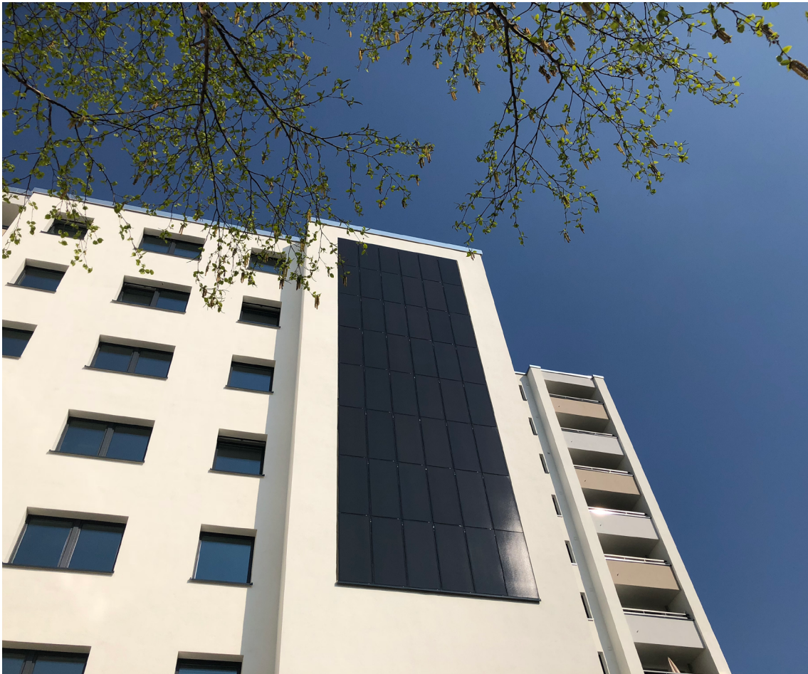
Eine der beiden PV-Fassadenanlagen im Quartier © Gasag Solution Plus
