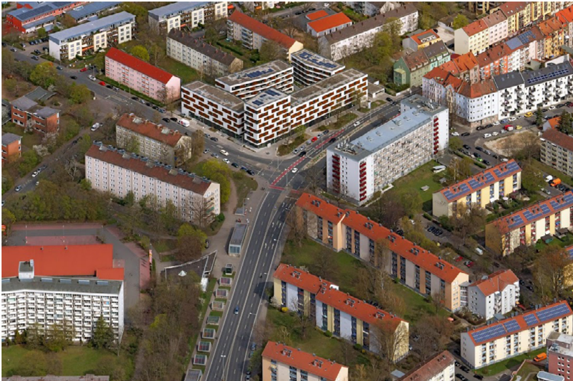
„Neues Wohnen Sündersbühl“, wbg Nürnberg, Foto: Stefan Meyer
