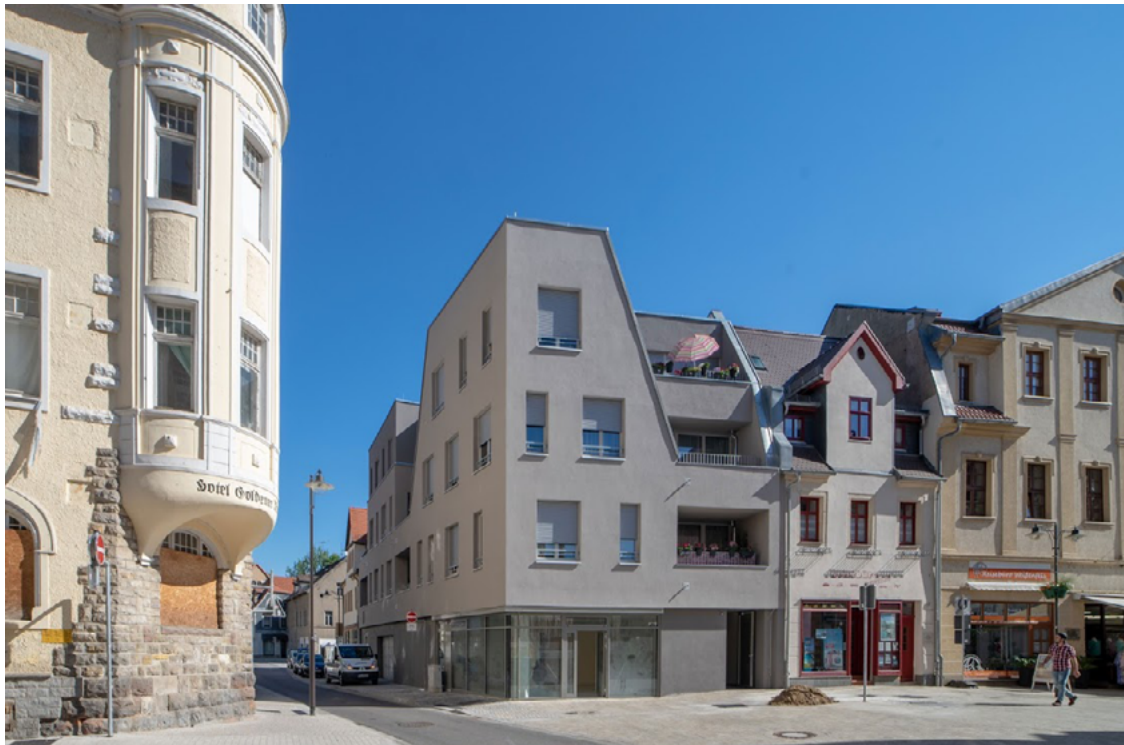
Das Projekt ‚Wohn- und Geschäftshaus Jüdenstraße‘, Wohnungsbaugenossenschaft Weißenfels/Saale eG.
