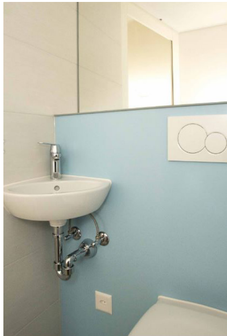
Die neu renovierten Bäder werden über Wärmeübergabe-Stationen versorgt
