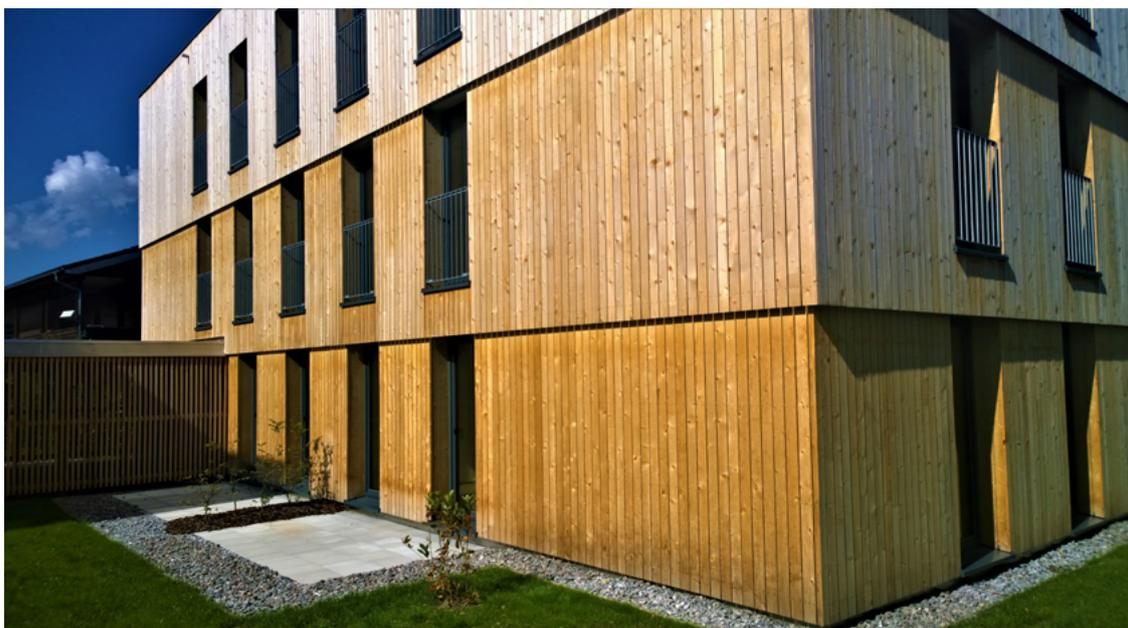
Geschosswohnungsbau in Modulbauweise, wenn es um bezahlbaren Wohnraum geht, ist dies eine Alternative. Hier Module in Holz, kurz vor der Fertigstellung. Tropfkanten je Stockwerk sind nicht nur eine gute optische Lösung, sondern auch eine präventive Lösung gegen Feuchteschäden. Foto: Gerd Warda
