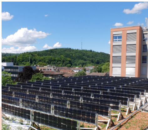
Innovation aus der Schweiz: Gründach mit Photovoltaik
