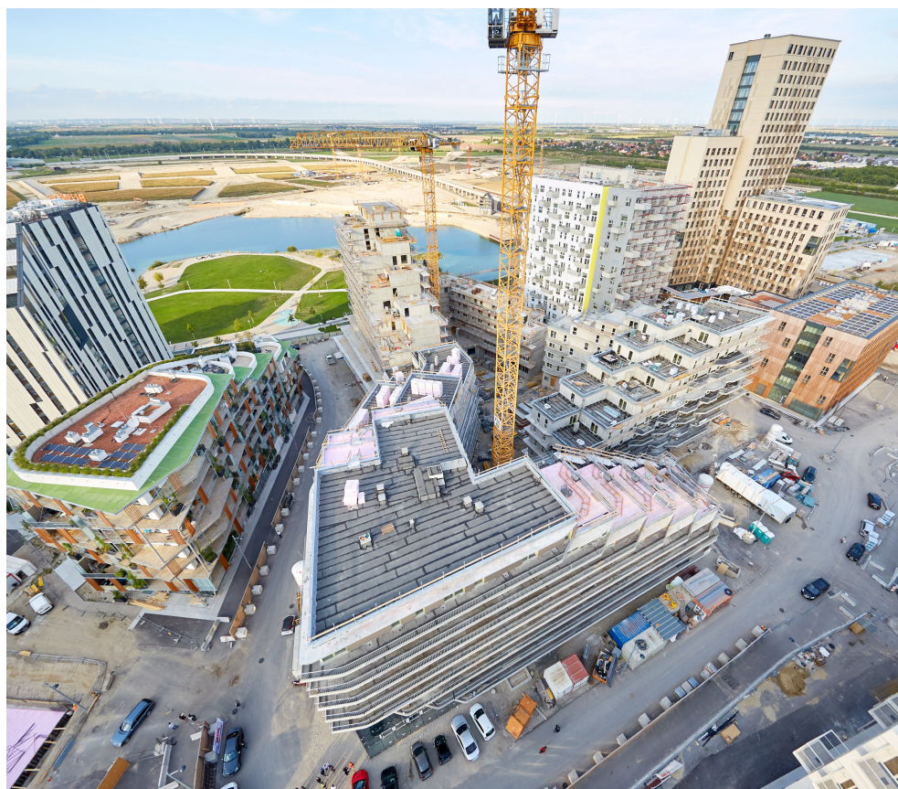
Sirius in der aspern Seestadt: Akademisches Gästehaus, Volkshochschule, Restaurant, wohnen, arbeiten, vom ÖSW und der WBV-GPA.
