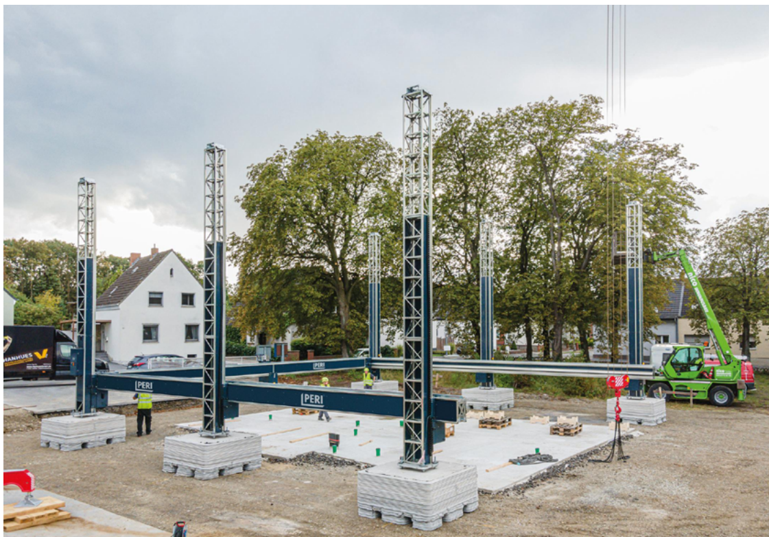
PERI druckt das erste Wohnhaus Deutschlands mit dem Portaldrucker BOD2 in Beckum, Nordrhein-Westfalen. Foto: PERI GmbH
