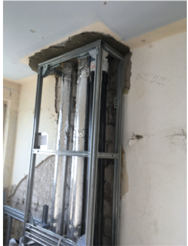
Das Foto rechts zeigt: Keine Verbindung zwischen den Geschossen, die Versorgungschächte können geschlossen werden.
