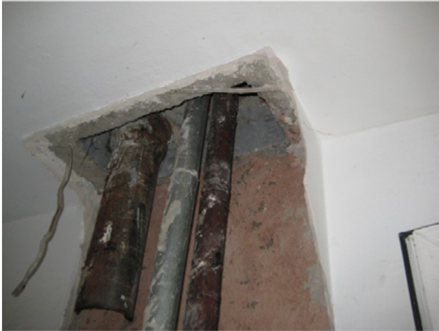
Das Foto rechts zeigt: Keine Verbindung zwischen den Geschossen, die Versorgungschächte können geschlossen werden.
