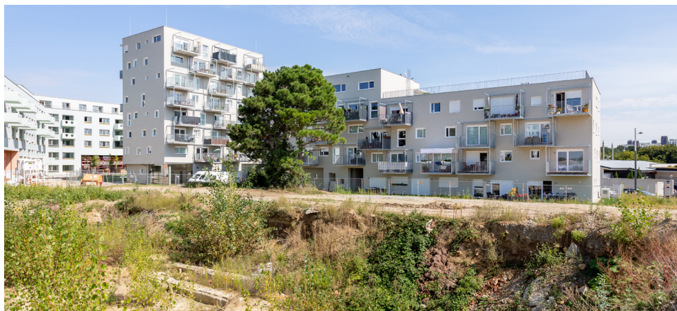
Baugruppe light im Mietshaus der EGW im Wildgarten: Mietgestalten von Caramel Architekten, 2020
