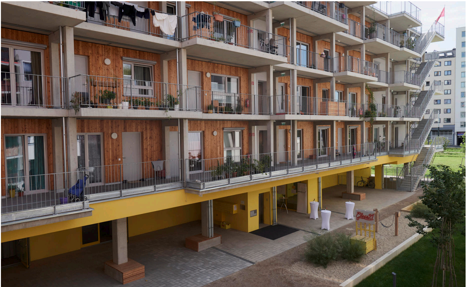
Das Baugruppenhaus Gleis 21 bietet zahlreiche Möglichkeiten für Begegnungen in allen Geschossen, auch vor den Wohnungstüren.
