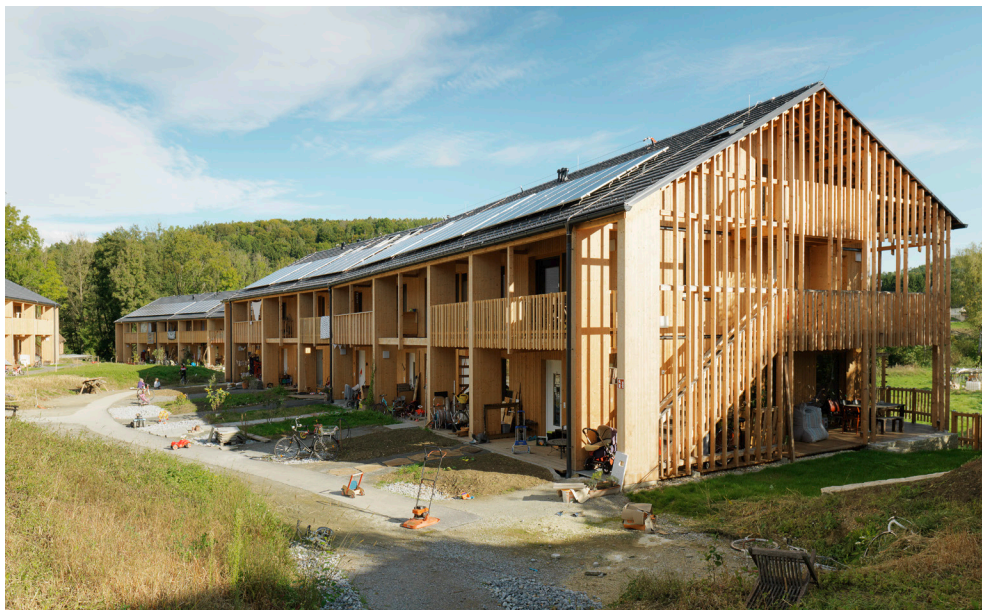
Ein ausgeklügeltes Energiemanagementsystem sorgt im KooWo Volkersdorf dafür, dass mit der hauseigenen PV-Anlage sowohl ein hoher Eigenverbrauchsanteil als auch hoher Autarkiegrad erreicht wird.
