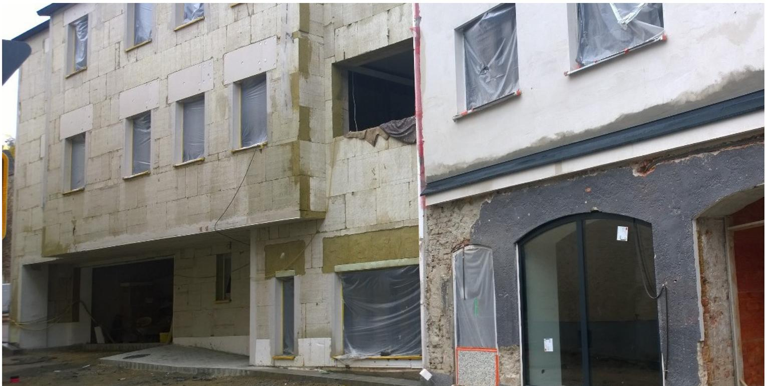
Schäden entstehen nicht nur wenn gebaut wird, sondern auch, wenn der Bau unterbrochen wird. Fehlt der Feuchteschutz, und sei es nur eine Abdeckung, kann Regen oder Schnee ungehindert Dämmung und Innenräume durchfeuchten. Foto: Gerd Warda
