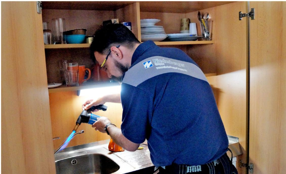
Vor der Probenentnahme muss der Entnahmehahn keimfrei sein. Foto: Niederberger
