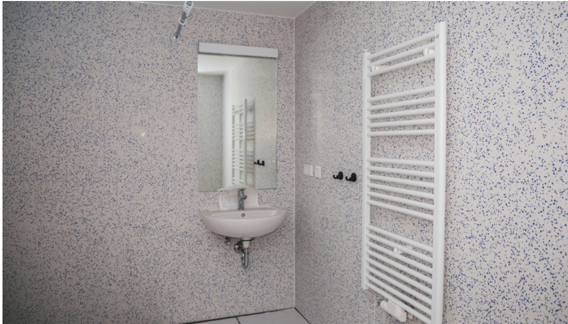
Ein Blick in das Badmodul. Alles ist fertig angeschlossen, fehlt nur die letzte Verbindung mit dem Haussystem. Foto: Karsten Socher
