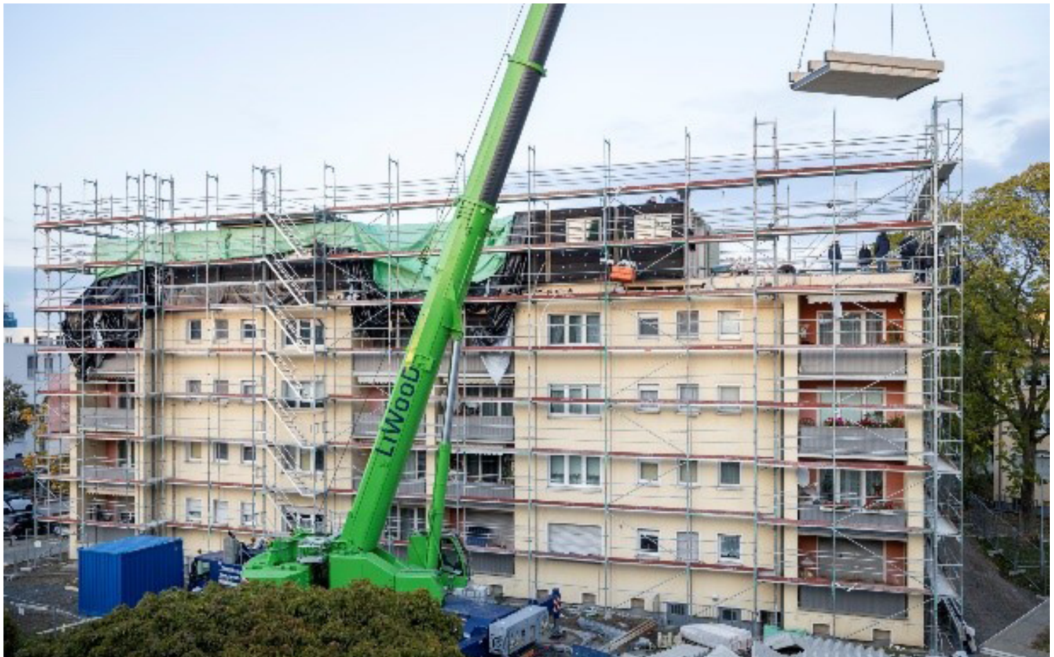
Aufstockung mit Modulen, Fritz-Kissel-Siedlung, Frankfurt am Main Foto: LiWood
