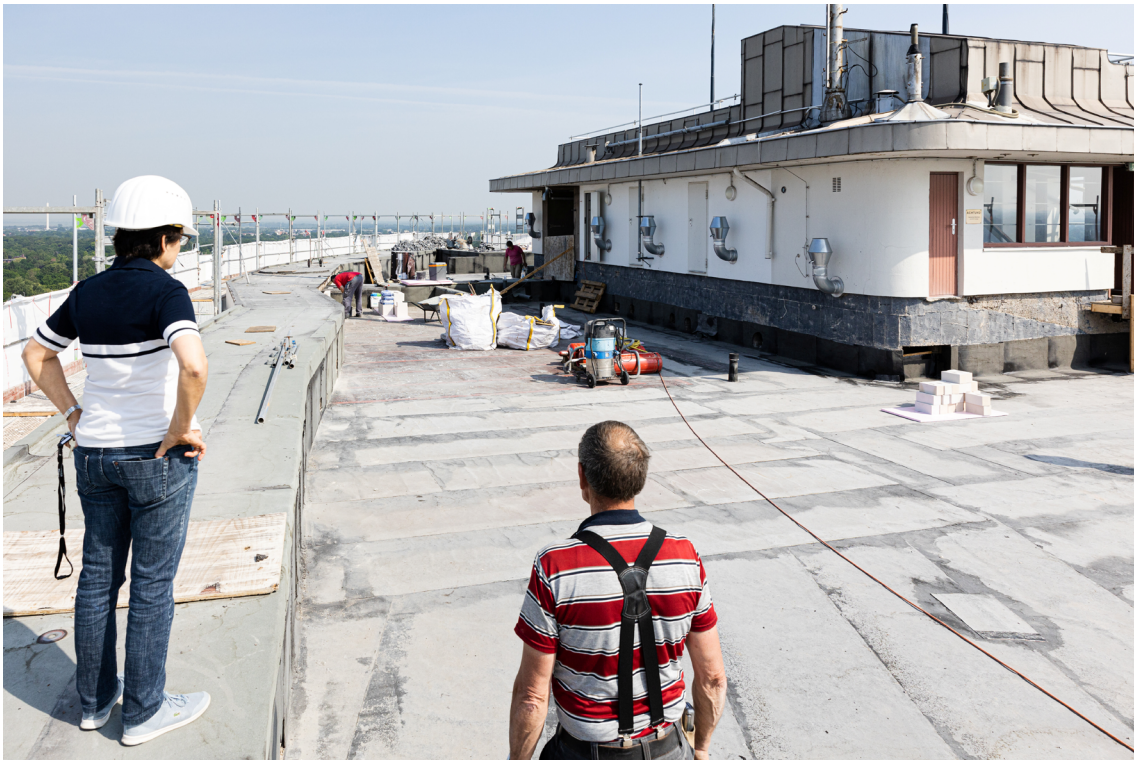
GEWOBA-Projektleiterin Nurdan Gülbas (li.) begutachtet die Rückbaumaßnahmen auf dem Dach des Aalto-Hochhauses. Foto: © Sven Warnke/GEWOBA
