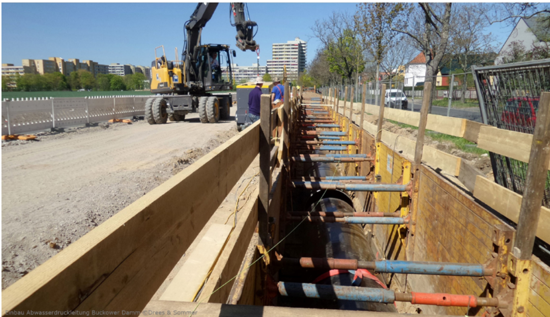
Im Buckower Damm wird eine Abwasserdruckleitung eingebaut. Bildrechte: Drees & Sommer
